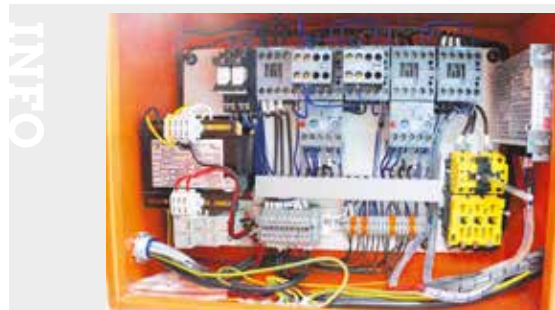
Armoire électrique DC complète
